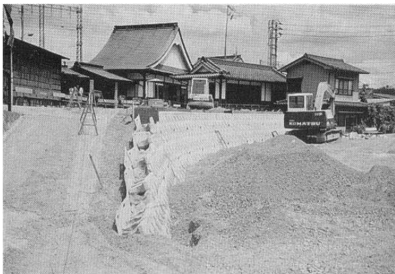
鐘楼基礎造成中（平成8年8月）
